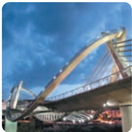
PUENTE DEL MILENIO · OURENSE
